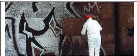
*Je nach Problem und Untergrund entfernen wir mit Wasser und Chemie oder mit einem Schon-Sandstrahlgerät*
